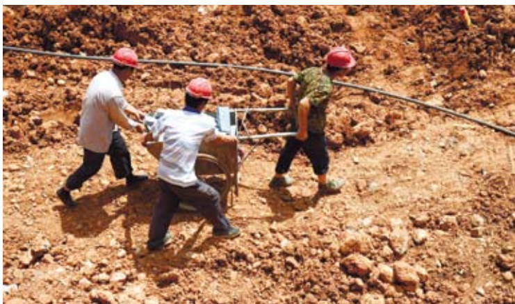
在濟南市濰文路人防工程現場，工人在烈日下勞作。當日，濟南市最高氣溫為38°C，山東省氣象臺發佈高溫橙色預警，一些勞動者依然堅守在工作崗位上。（新華社 郭緒雷 攝）
